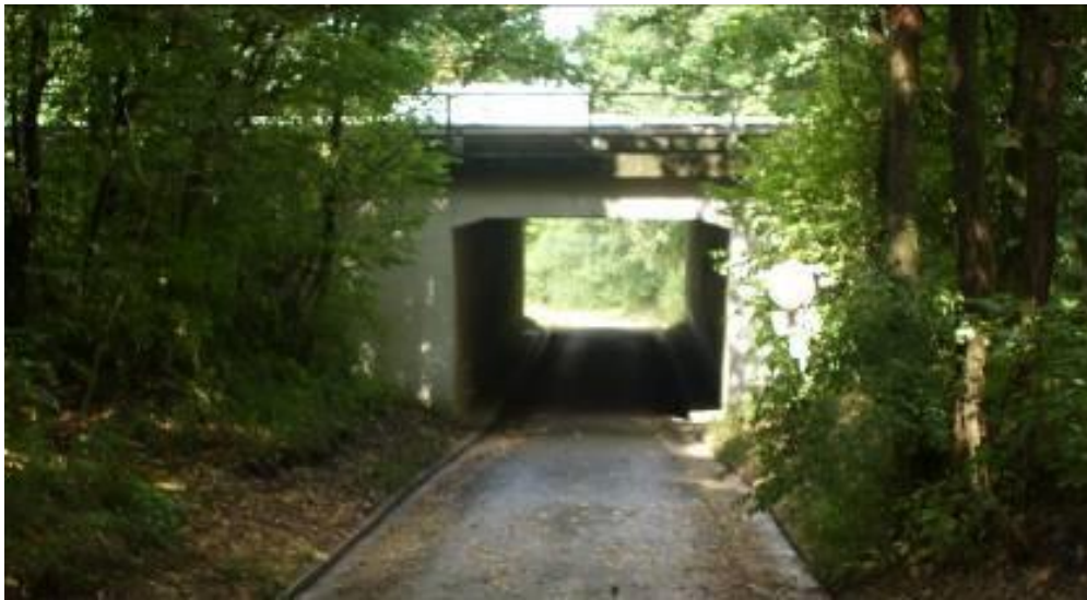
Wirtschaftswegunterführung im Klosterforst bei Bau-km 311+165
